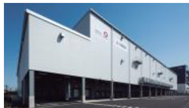
Dプロジェクト北八王子C棟
