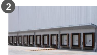
ドックシェルター 荷役作業の際の外気・雨風・湿気・塵等の侵入を防止
